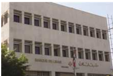
BANQUE DU LIBAN Waterproofing
