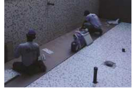
لياسة، صب الأرضية، أعمال العزل المائي، لصق البلاط ومد الروبة
